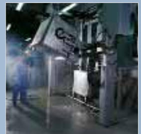
Wasch- und Reinigungsanlagen
